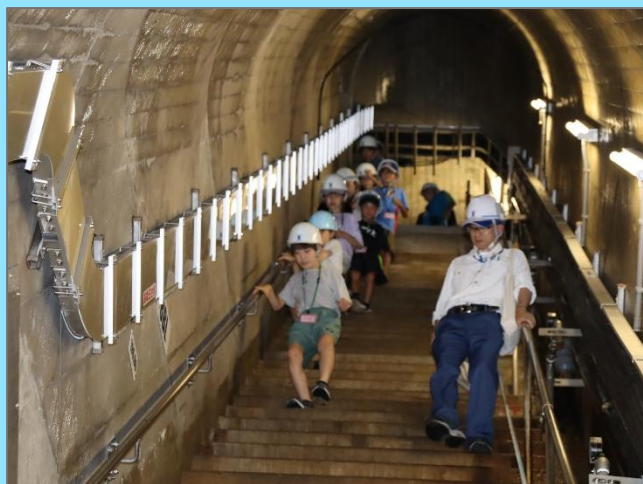
大島ダムの監査廊（ダム内の通路）
