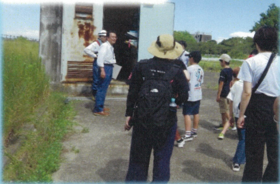
監査廊の出入口
