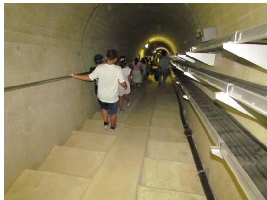
監査廊の階段 約 130 段
